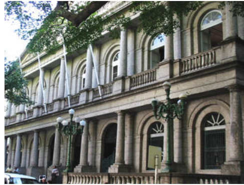
Imagem 3 – Hospital Geral – foto atual.
